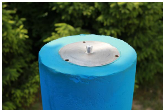
Rys. 2.6. Słup bazy po zdjęciu szalunku i wykończony
