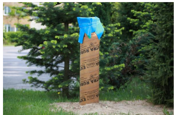
Rys. 2.5. Stopa fundamentowa i słup w szalunku kartonowym
