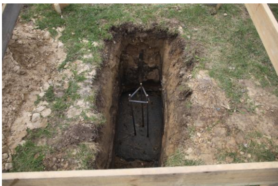
Rys. 2.5. Stopa fundamentowa i słup w szalunku kartonowym
