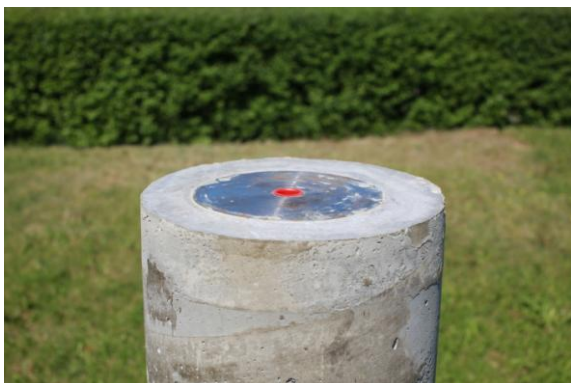
Rys. 2.6. Słup bazy po zdjęciu szalunku i wykończony
