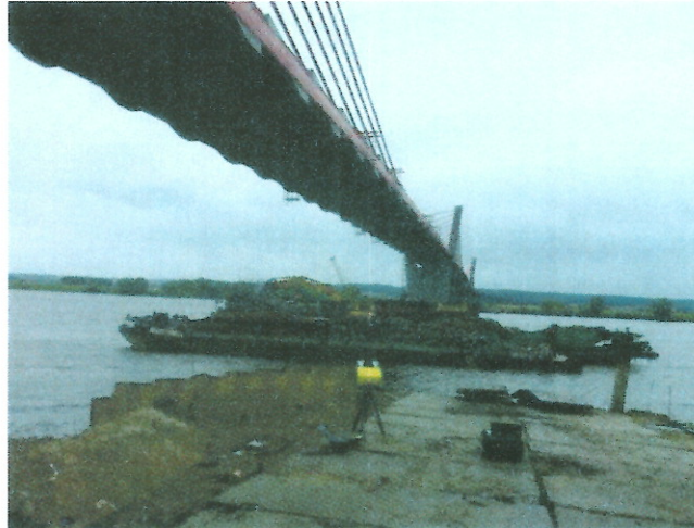
Rys. 14 Jedno z przęseł nurtowych mostu w Kwidzynie. Kable sprężające poprowadzone poza przekrojem dźwigara przypominają ustrój wantowy. Źródło: publikacja numer 8.
