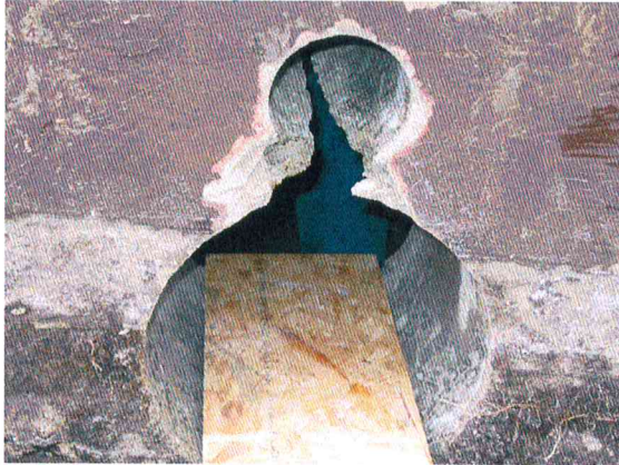
Wzmocnienie muru fundamentowego plombą żelbetową; utworzenie konsolki technologicznej
