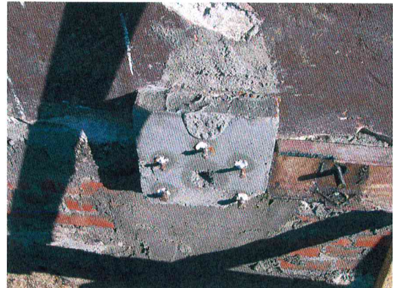
Wzmocnienie muru fundamentowego plombą żelbetową; utworzenie konsolki technologicznej
