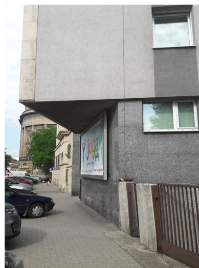
Rys. 9. Budynki z nawisem podpartym filarem i nawisem nie podpartym filarem. Zdjęcia: M. Buśko [C7]
