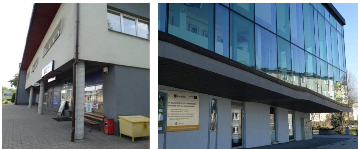
Rys. 10. Budynki z nawisami: podpartym filarami i nie podpartym. Zdjęcia: M. Buško [C7]
