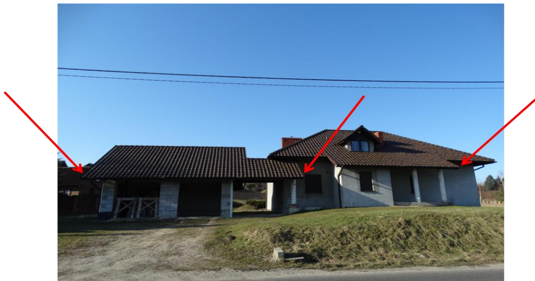
Rys. 3. Budynek z dachem opartym na filarach. Zdjęcie: M. Buśko [C3]
